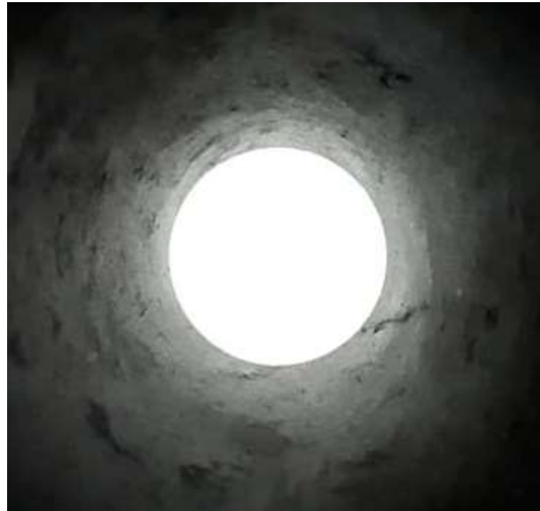
Buse non usée, surface et bords sans défaut – diamètre conforme à l'état initial
