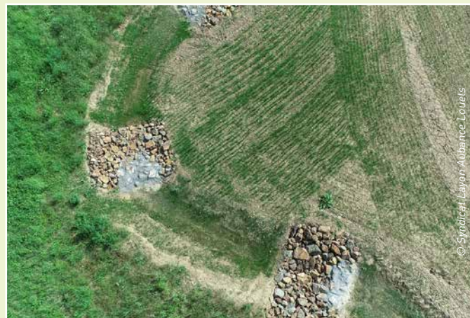
Photo 2 : Noüe végétalisée à redents
