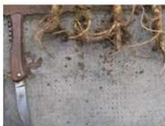
Problème de structure (CA GE)
